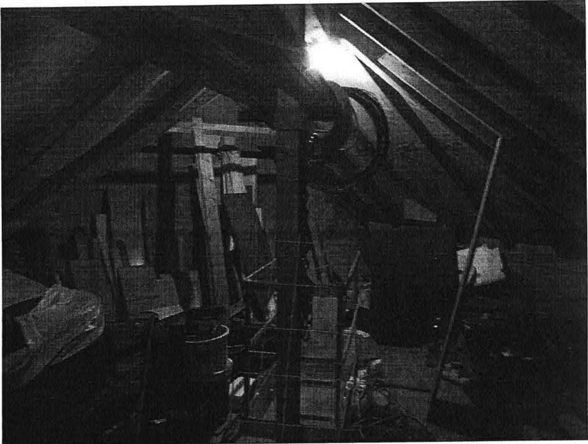
Abbildung 5: Dachboden mit Luke und Bodentreppe
