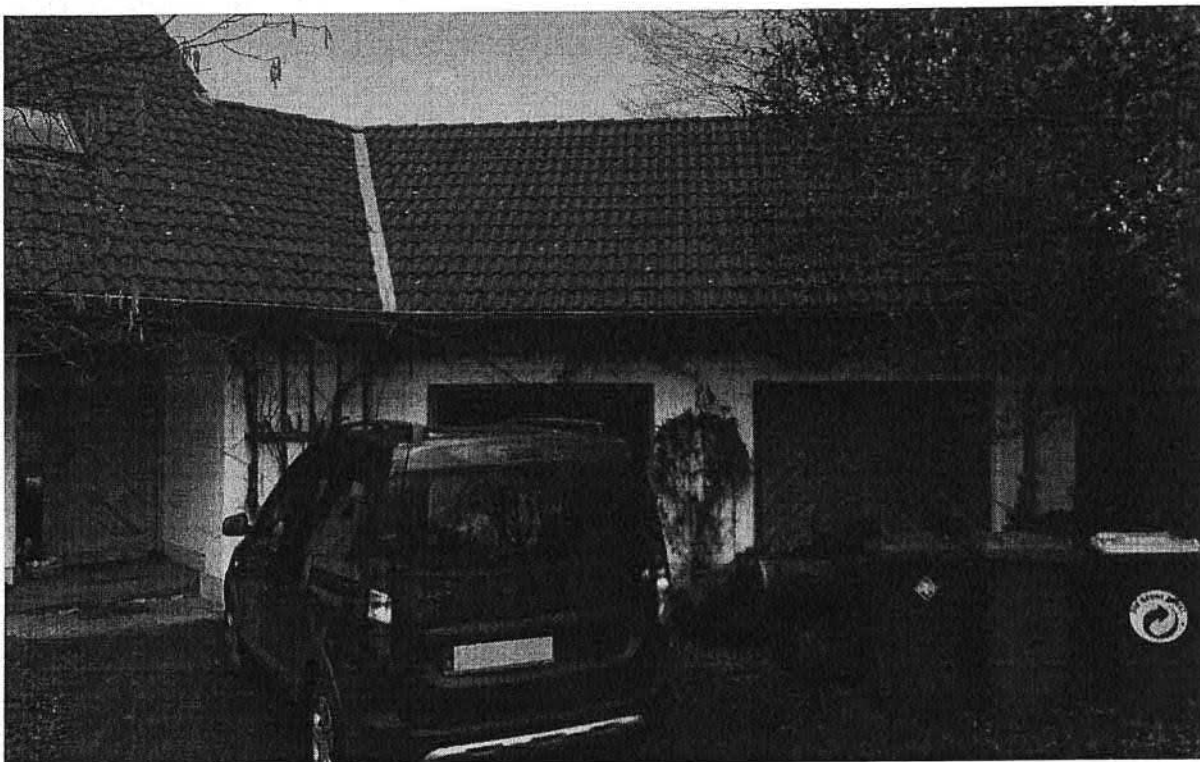
Abbildung 3: Blick auf Garage neben bestehendem Wohnhaus mit Blick aus Richtung Süden
