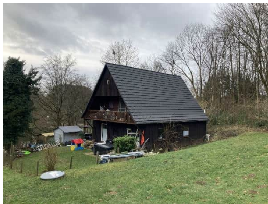
Abb. 11 Wohngebäude im Plangebiet.
