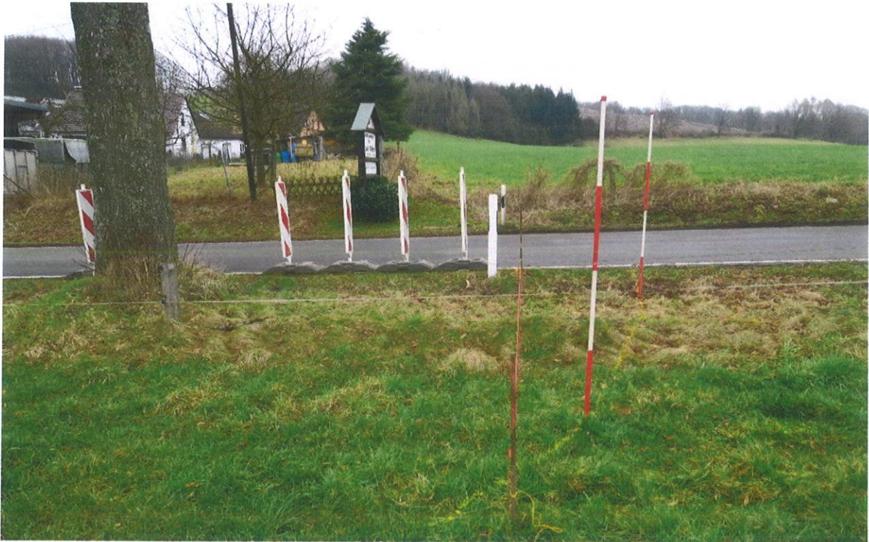
Abb. 8: Bereich Linde Nr. 1, Ansicht von Süden. Absteckung des Wurzelsuchgrabens und der Kronentraufe mittels Fluchtstäben. Bereits die Ausdehnung der Kronentraufe lässt eine Wurzelentwicklung in den Baubereich vermuten.
