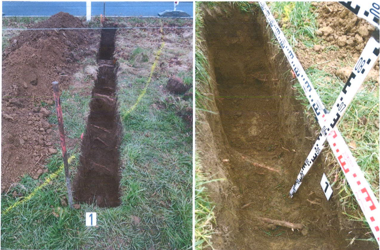
Abb. 14 (l.) und 15: Ansicht von Süden, fertiggestellter Suchgraben an Baum Nr. 1. Die Grabungstiefe unter OK Gelände wurde - in Abhängigkeit von zu erhaltenden Wurzelorganen - bis zu 0,80 m ausgeführt.
