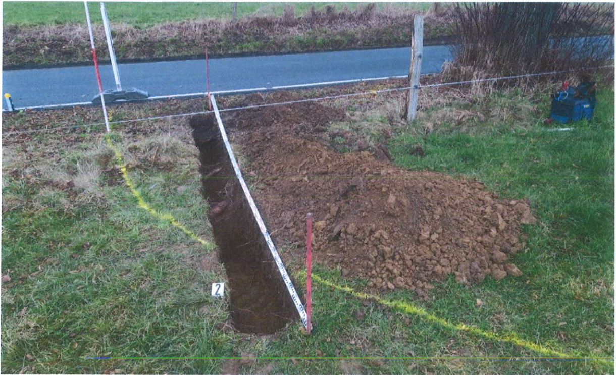
Abb. 12: Ansicht Sondierungsgraben Bereich Linde, Baum Nr. 2.
