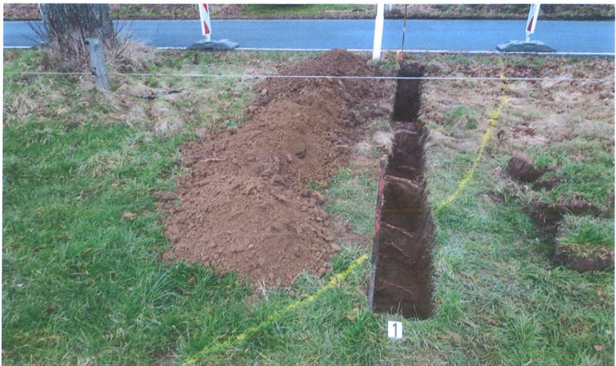
Abb. 11: Ansicht Sondierungsgraben Bereich Linde Nr. 1, Ansicht von Süden.
